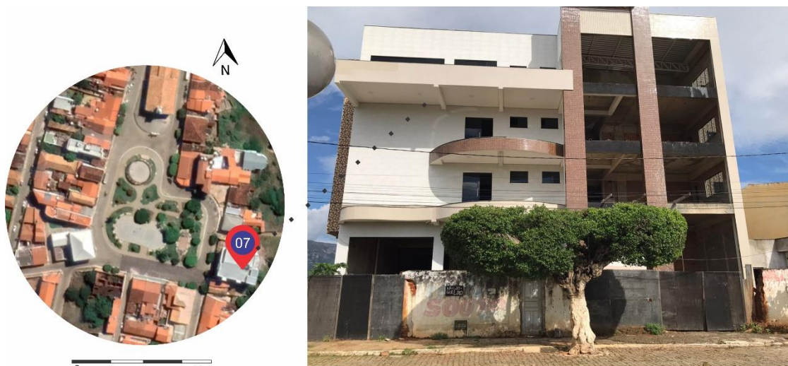
Figura 21 - Shopping em Construção, 2021
