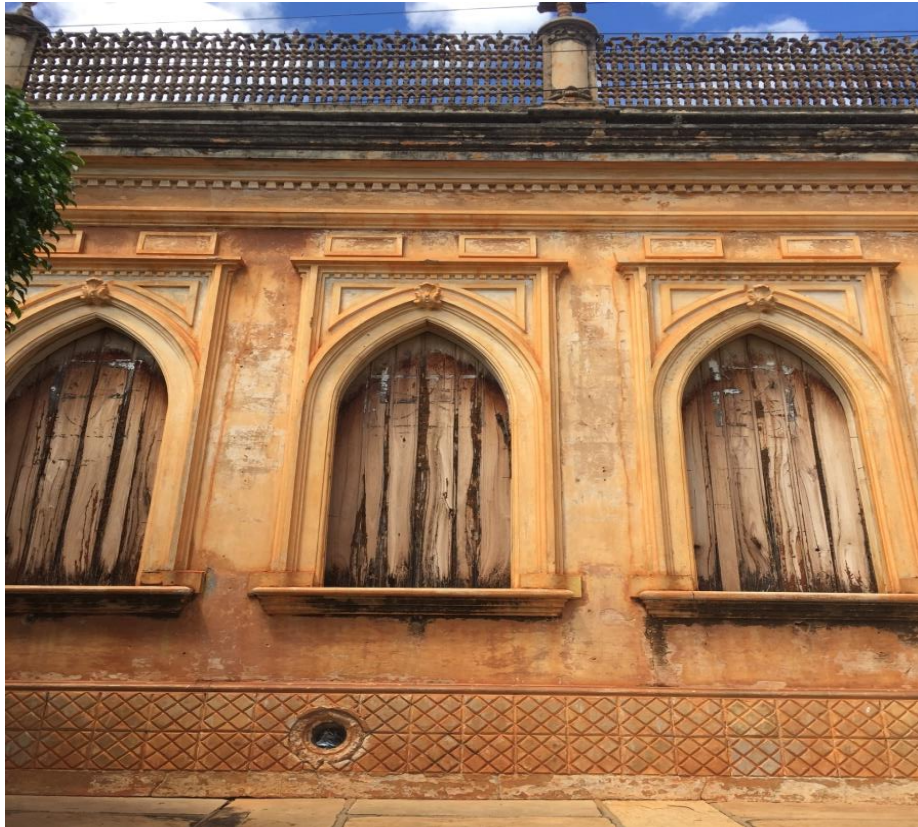
Figura 40 – Janelas e platibanda rebuscada para Rua Francisco Otaviano Tanajura
