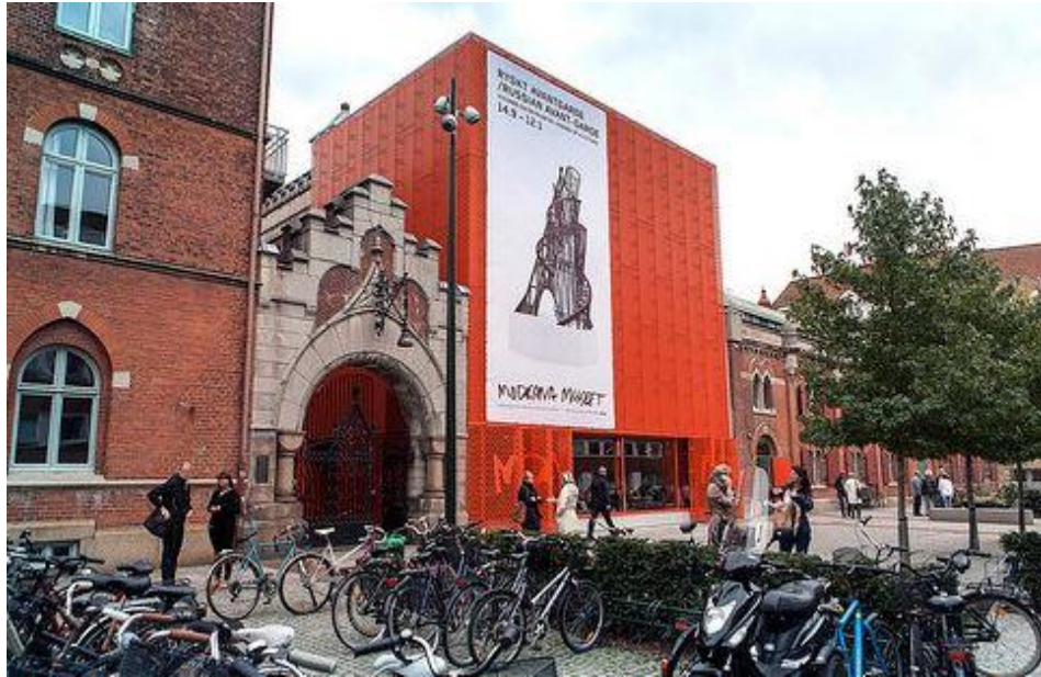
Figura 14 – Fachada do Museu de Arte Moderna de Malmö
