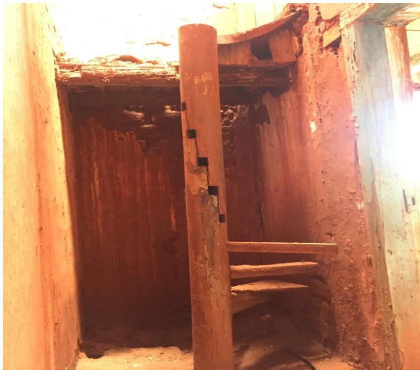
Figura 47 – Escada helicoidal de acesso ao sótão
