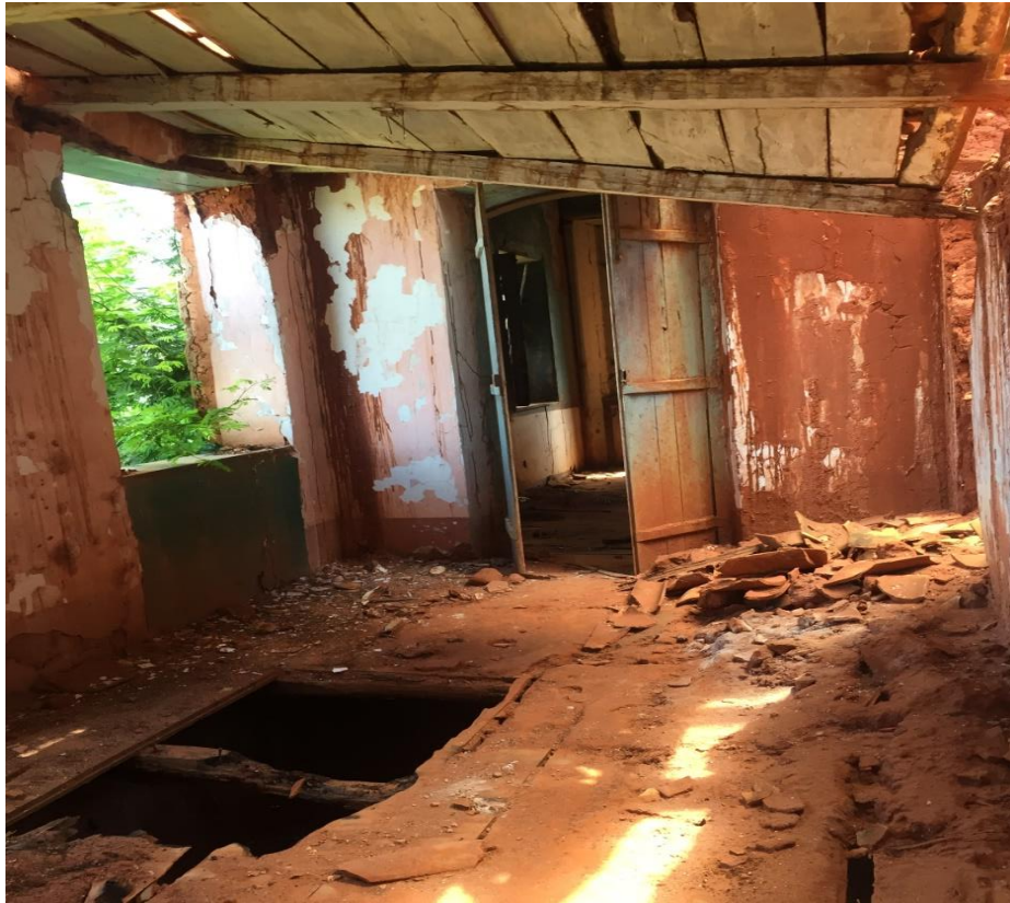
Figura 46 – Sala de acesso ao porão
