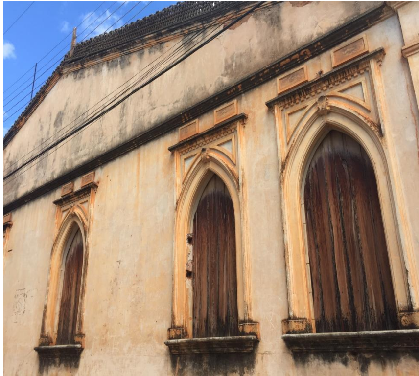
Figura 42 – Fachada lateral para Rua João Pessoa
