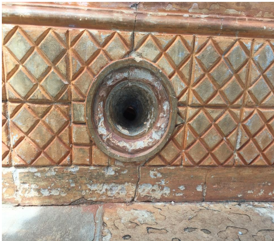
Figura 41 – Detalhe na fachada
