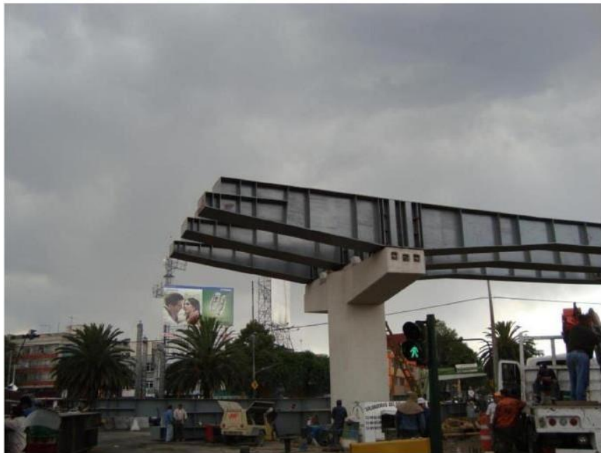
OBRA PUENTE VEHICULAR PERIFERICO SECTOR PÚBLICO
