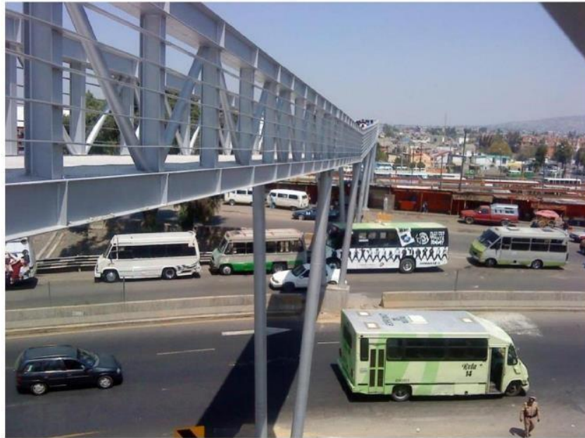
OBRA PUENTE PEATONAL SECTOR PÚBLICO
