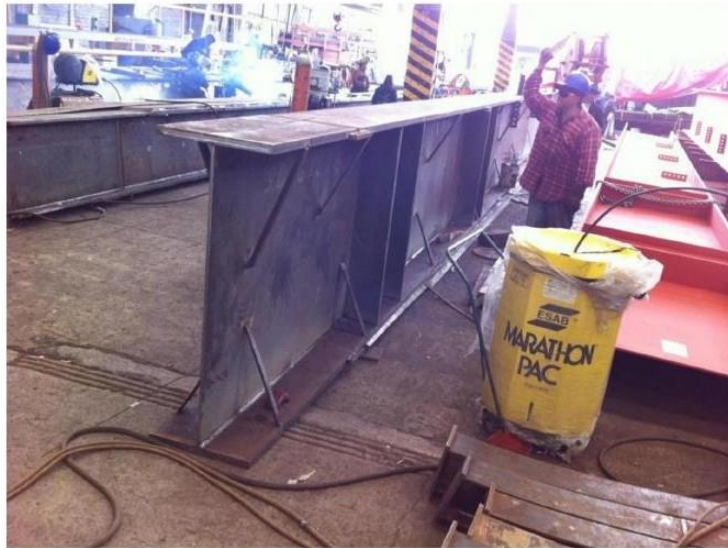
OBRA PUENTE VEHICULAR TOREO SECTOR PÚBLICO
