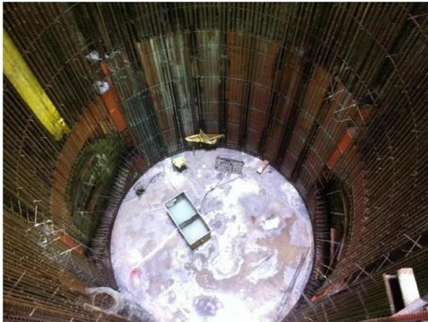
OBRA LUMBRERAS SECTOR PÚBLICO
