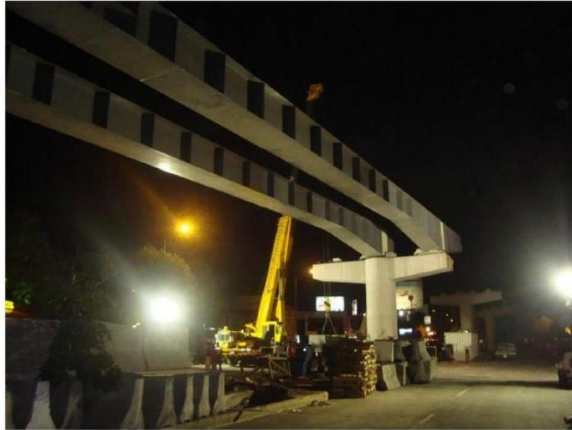
OBRA PUENTE VEHICULAR CHURUBUSCO SECTOR PÚBLICO
