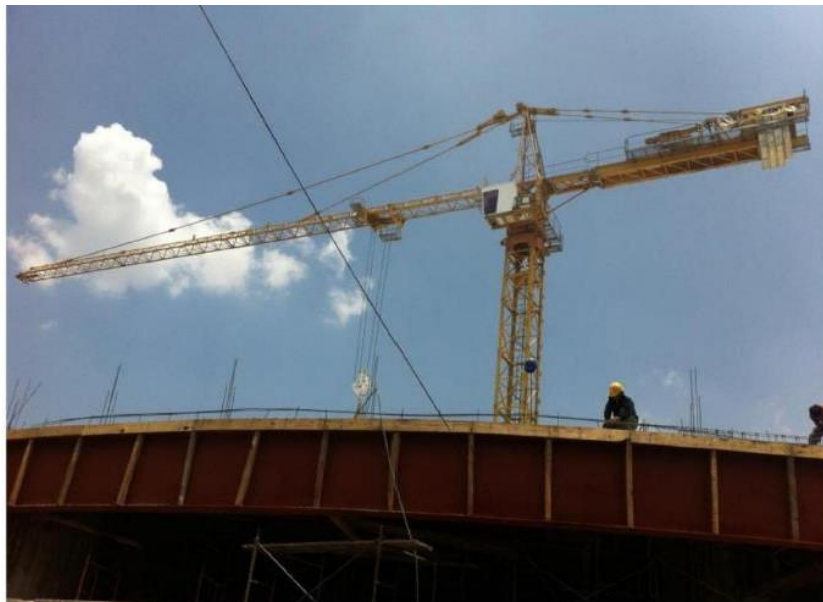
OBRA CETRAM SECTOR PÚBLICO
