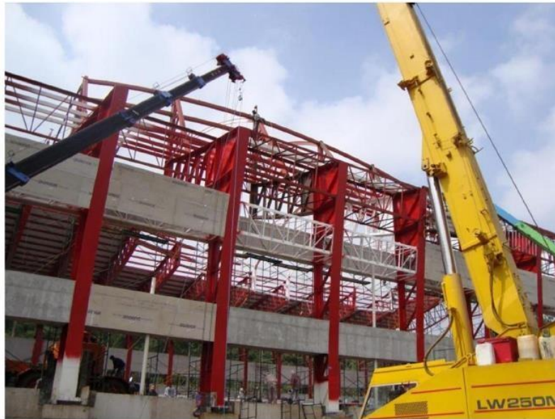
OBRA ALBERCA OLIMPICA SECTOR PÚBLICO
