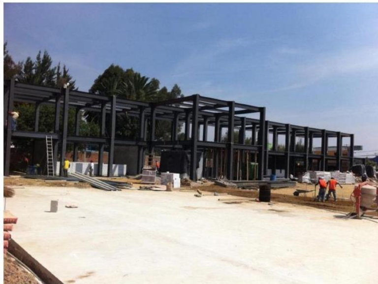
OBRA ESCUELAS SECTOR PÚBLICO
