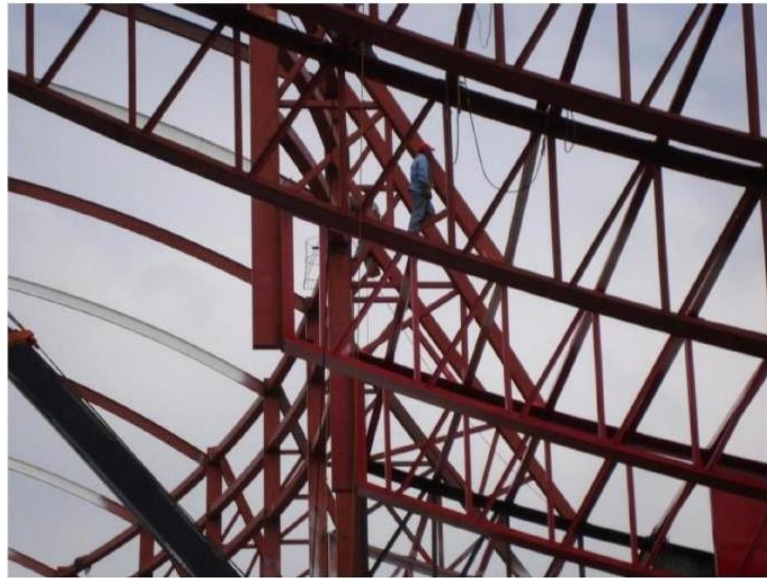
OBRA ALBERCA OLIMPICA SECTOR PÚBLICO
