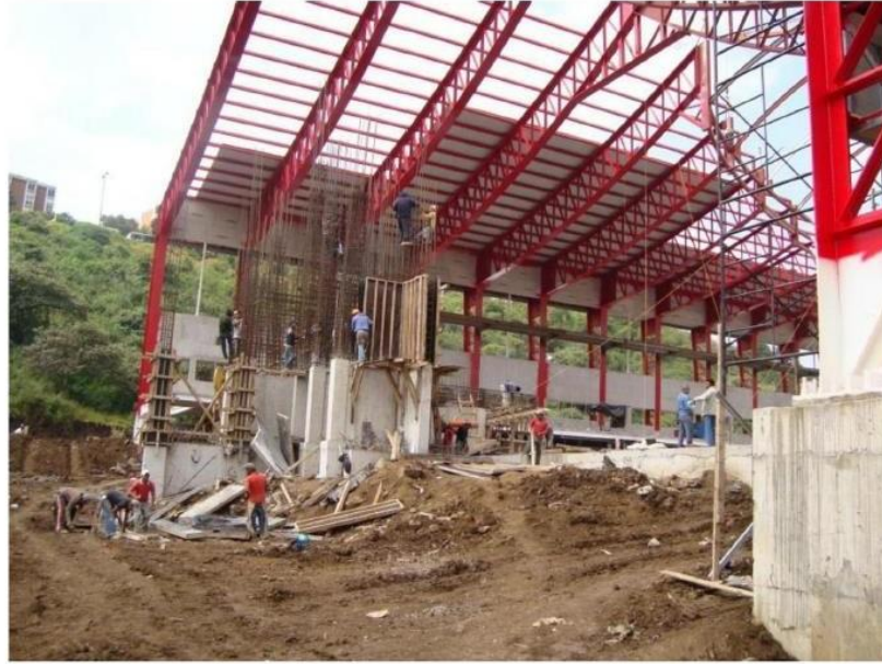
OBRA ALBERCA OLIMPICA SECTOR PÚBLICO
