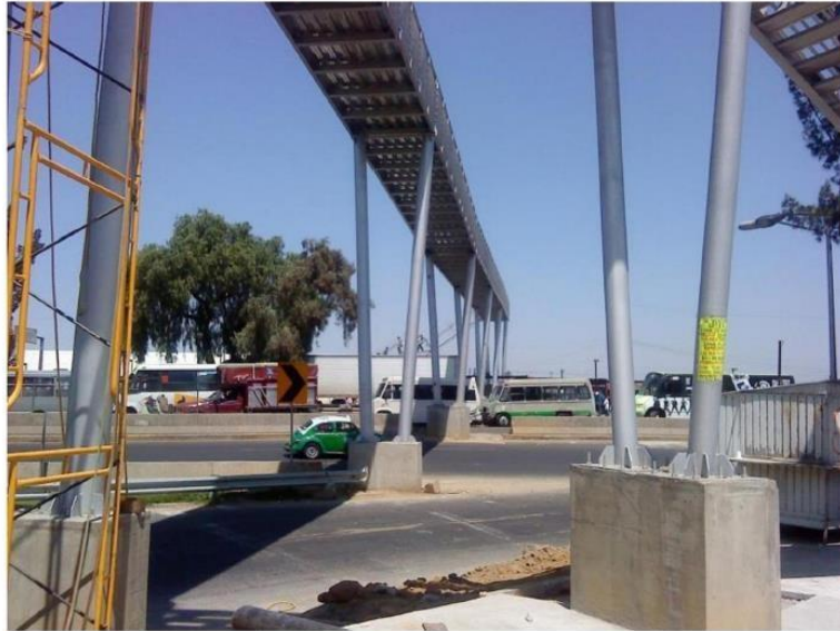
OBRA PUENTE PEATONAL SECTOR PÚBLICO
