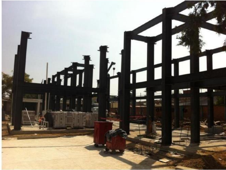
OBRA ESCUELAS SECTOR PÚBLICO
