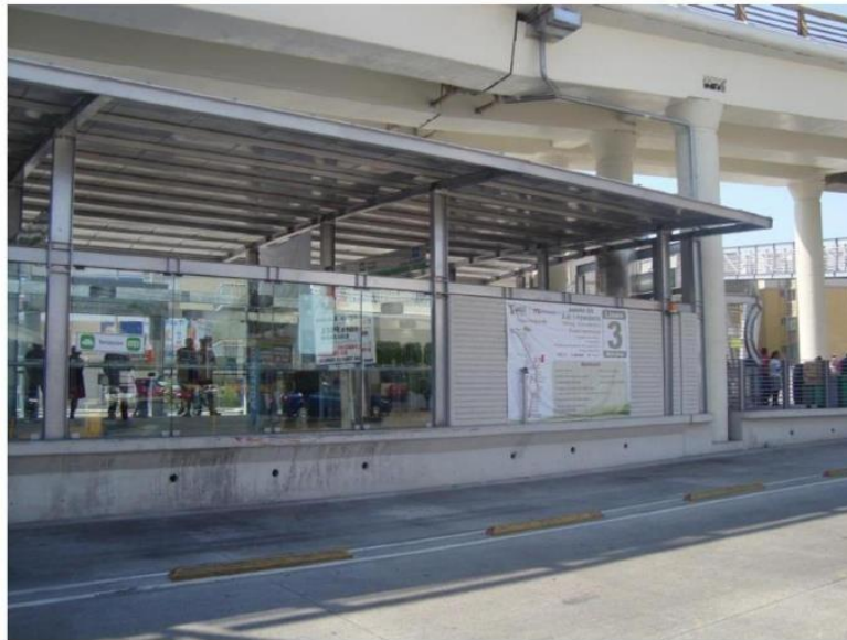
OBRA METROBUS SECTOR PÚBLICO
