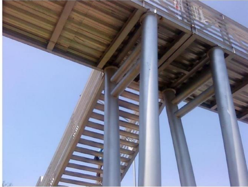
OBRA PUENTE PEATONAL SECTOR PÚBLICO
