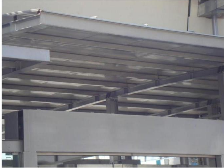
OBRA METROBUS SECTOR PÚBLICO
