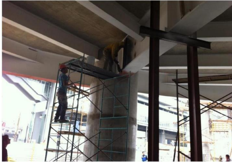
OBRA CETRAM SECTOR PÚBLICO
