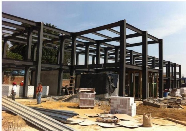
OBRA ESCUELAS SECTOR PÚBLICO
