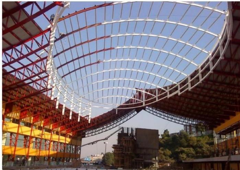
OBRA ALBERCA OLIMPICA SECTOR PÚBLICO
