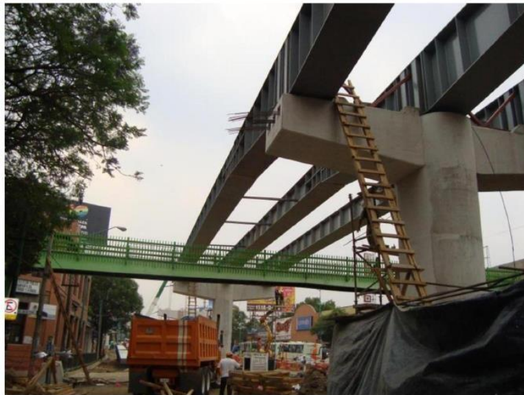
OBRA PUENTE VEHICULAR PERIFERICO SECTOR PÚBLICO
