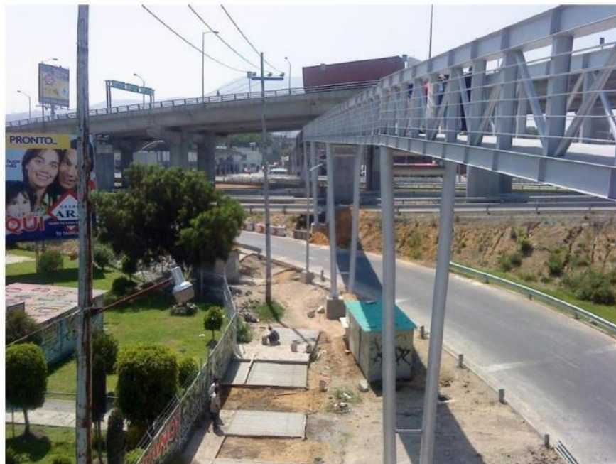
OBRA PUENTE PEATONAL SECTOR PÚBLICO
