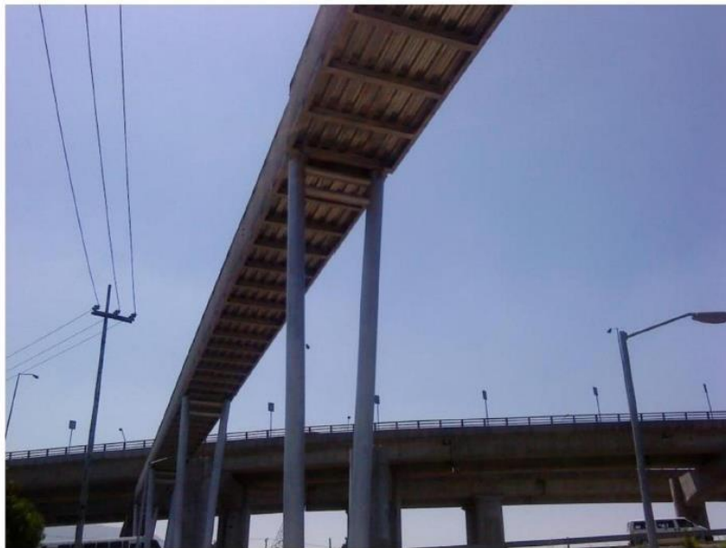
OBRA PUENTE PEATONAL SECTOR PÚBLICO
