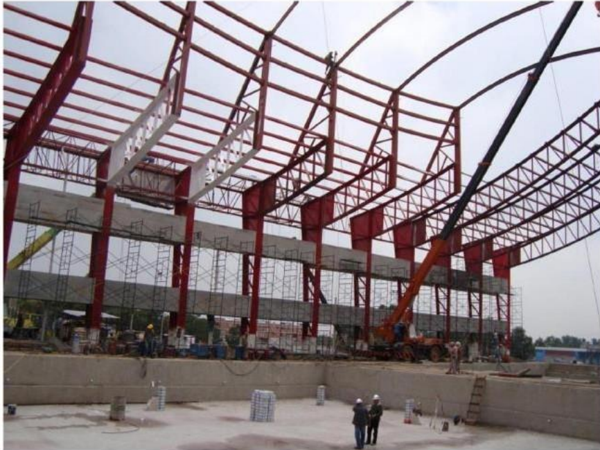
OBRA ALBERCA OLIMPICA SECTOR PÚBLICO
