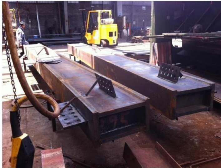
OBRA CETRAM SECTOR PÚBLICO
