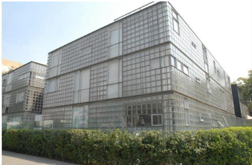
OBRA EDIFICIO VITROBLOCK POLANCO SECTOR PRIVADO
