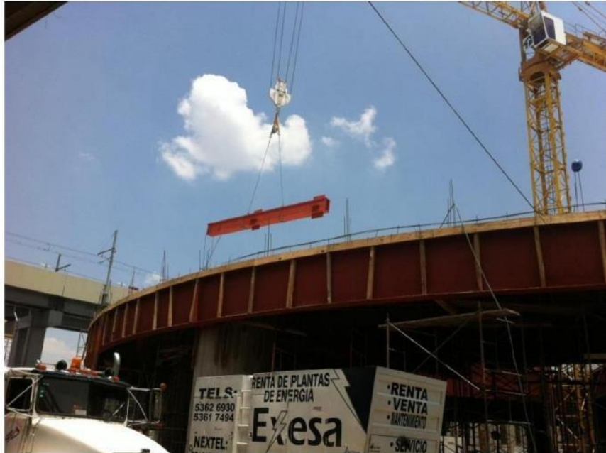
OBRA CETRAM SECTOR PÚBLICO
