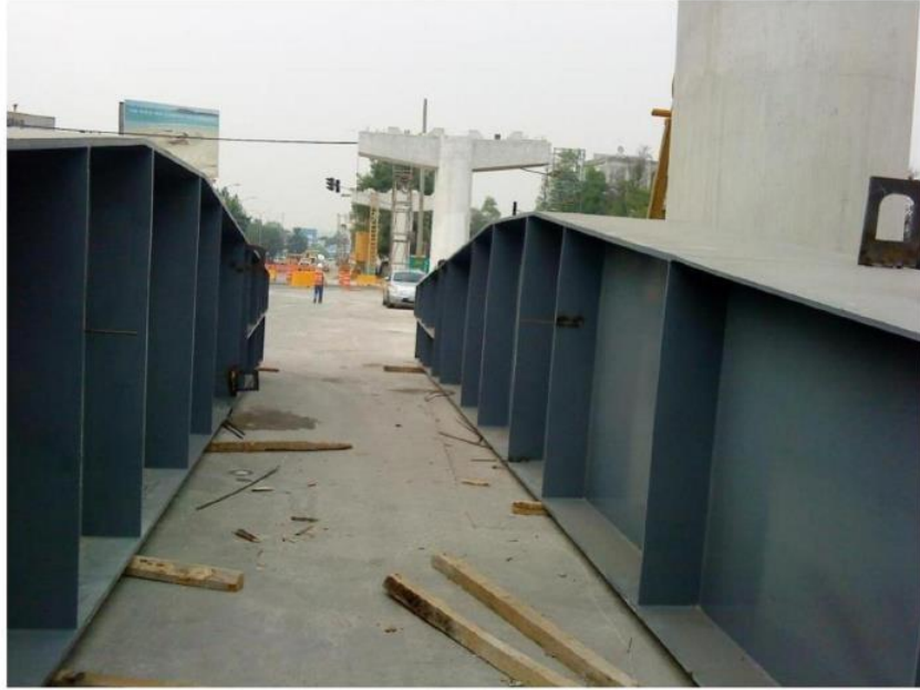
OBRA PUENTE VEHICULAR PERIFERICO SECTOR PÚBLICO
