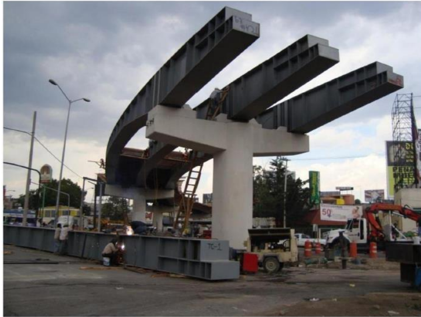
OBRA PUENTE VEHICULAR PERIFERICO SECTOR PÚBLICO
