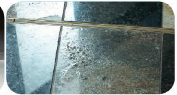
SPALLING
