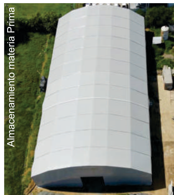
Bodega cubrimiento en Teja Acero o U PVC
