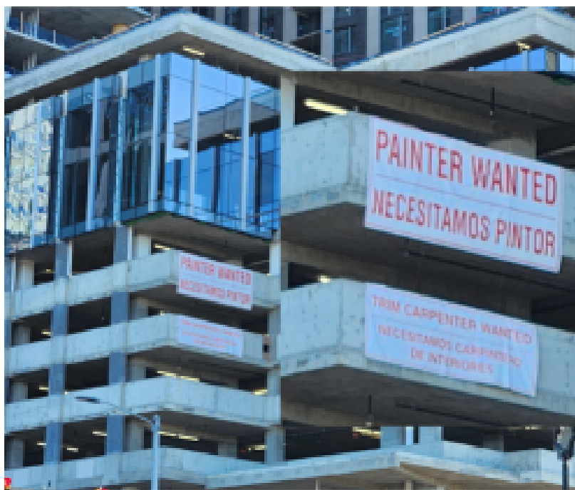
Figura 3: Muestra un edificio en Rosslyn en Arlington, Virginia, que está al otro lado del río Potomac con dos pancartas: la de arriba dice «painter wanted» y «necesitamos pintor» abajo. La de abajo dice «trim carpenter wanted» y «necesitamos carpintero de interiores» abajo. Foto por Dr. Ernesto Castañeda (2023).
