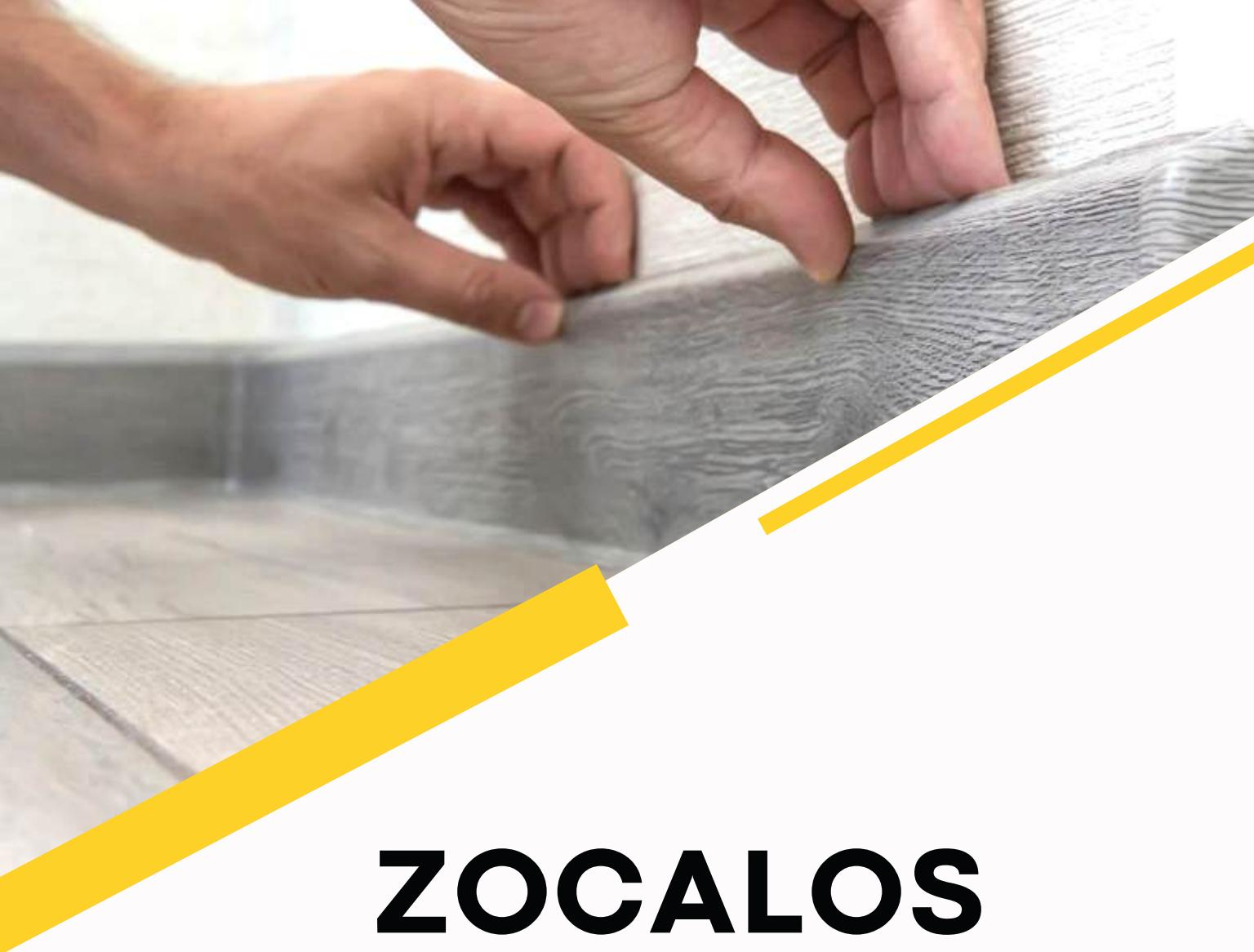
El Sistema de Zócalo representa un elemento fundamental porque protege la parte inferior del muro de los golpes, de las abrasiones y esconde eventuales irregularidades o imperfecciones presentes entre el muro y el suelo
