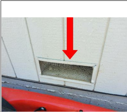
Broken bent vent
