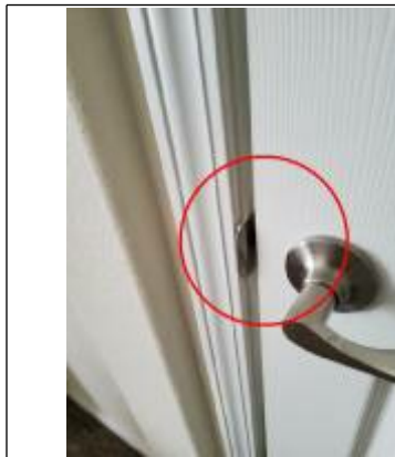
readjust door jamb plate
