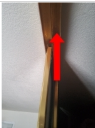
Lubricate closet door track
