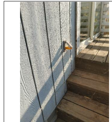
Open Nuetral on outlet detected.
