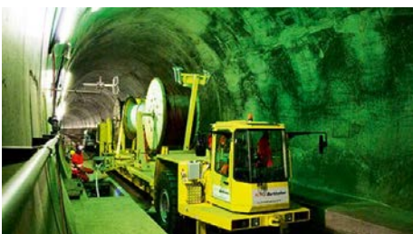
Kabeleinzug Gotthard Basistunnel
