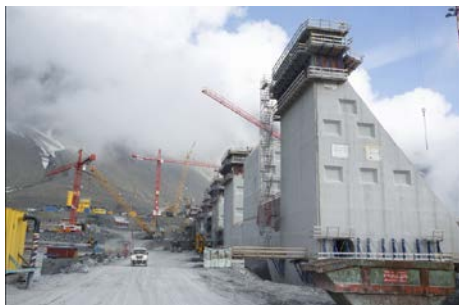
Staumauerbau Projekt Linthal 2015
