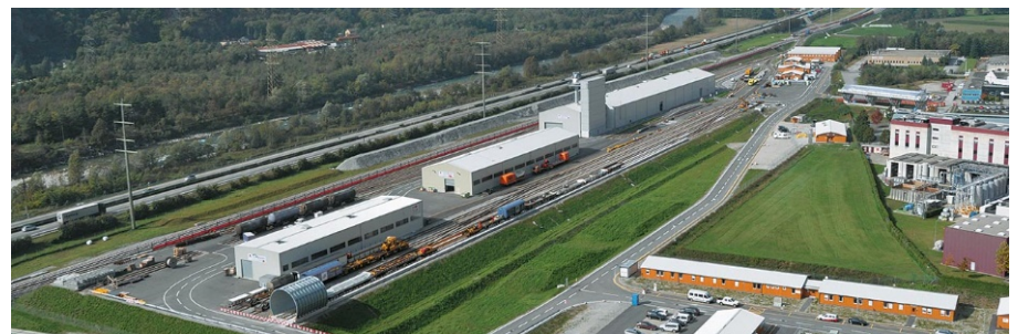
Installationsplatz für den Einbau der Bahntechnik in Biasca
