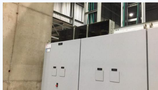
ÁREA EXTERNA QGBT
