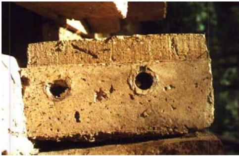
resistente que transmitiera las cargas a las vigas, y estas los correspondientes muros que les soportaban. Esta pieza de entrevigado iría apoyada directamente sobre las vigas de madera por medio de unos encajes. Está reforzado con dos cañas de bambú de 4 cm. De diámetro, que serán las que absorberán la mayor parte de la carga que gravite sobre el elemento.
