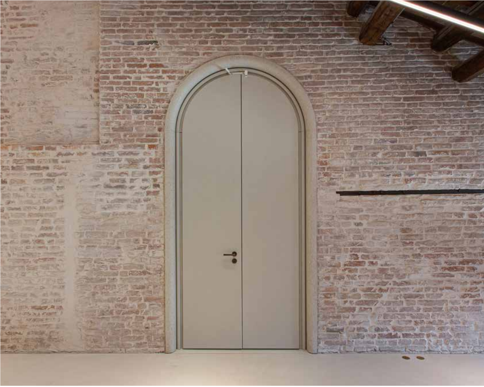
Porte doppie ad arco resistenti al fuoco 60 minuti in finitura effetto cemento.
