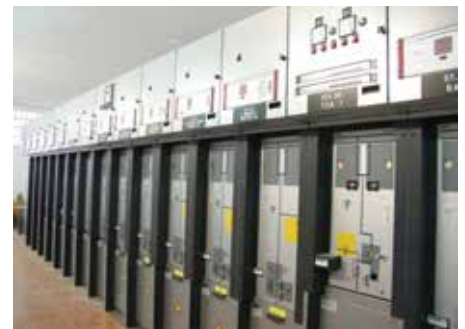
Subestación de compañía eléctrica española (España)
