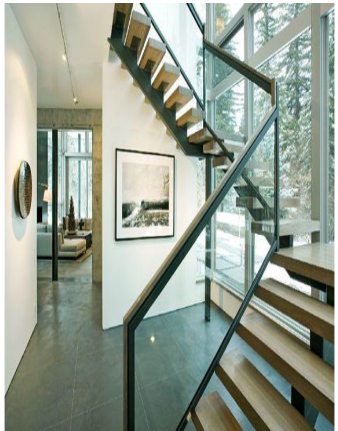
MODE: FF-020103 مدل: فریم فلزی رنگ شده HANDRAIL: T00-02010403 هندریل: مربعی فلزی رنگ شده و چوبی
