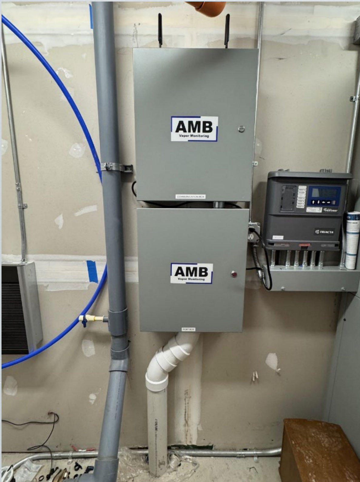
View of the installed AMB Vapor Monitoring Telemetry System
