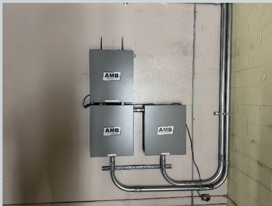
View of AMB Vapor Monitoring Telemetry System.
