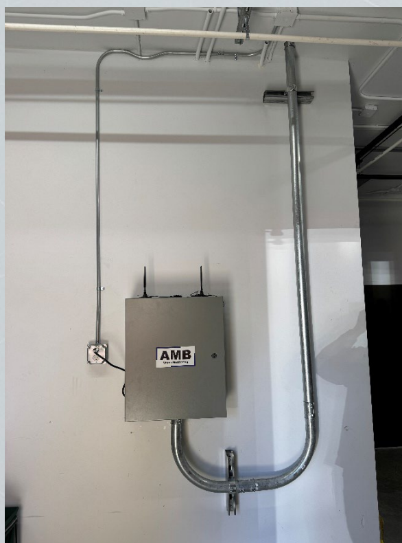
View of AMB Vapor Monitoring Telemetry System.
