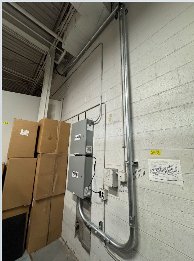
View of AMB Vapor Monitoring Telemetry System.
