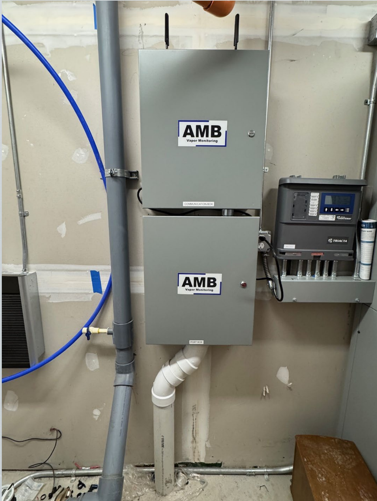
View of AMB Vapor Monitoring Telemetry System.
