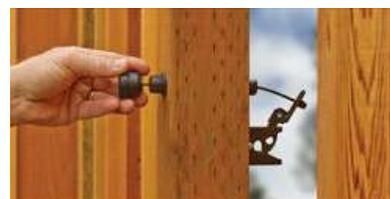
Le système de verrouillage et de fermeture automatique doit être constitué de dispositifs fixés en permanence. Aucun dispositif ne doit permettre d'ouvrir la barrière à partir de l'extérieur de l'enceinte ou d'empêcher son fonctionnement.
