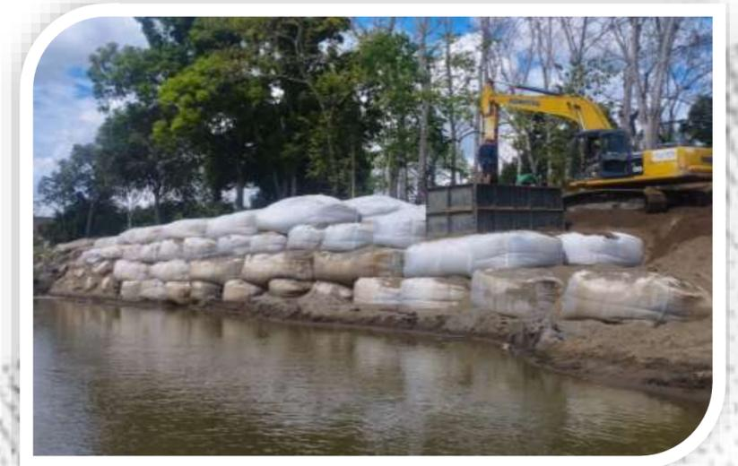
**SUPERBAG 1M3:** geobolsas fabricadas con geotextil tejido de polipropileno para ser llenadas con suelo del sitio o agregados de construcción. Presentan forma de prisma rectangular con capacidad para aproximadamente 1 m<sup>3</sup>
