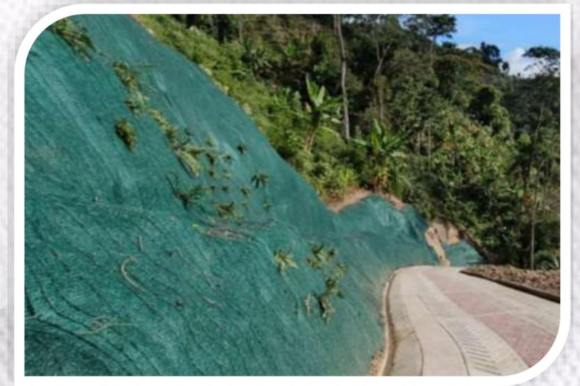
**GeoMANT (TRM):** diseñado para ofrecer protección inmediata contra la erosión, proporcionar soporte en el establecimiento y crecimiento de la vegetación y ser un refuerzo permanente para la vegetación madura.
