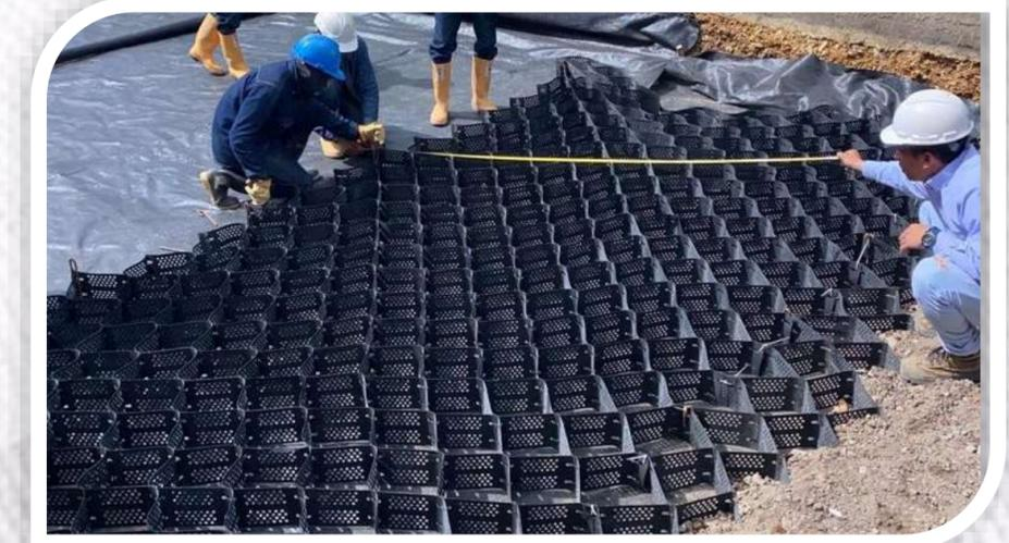
**GEOMALLAS:** Uniaxiales, biaxiales y triaxiales con alta capacidad de entramamiento para refuerzo de capas granulares en muros, pavimentos, pisos industriales.
