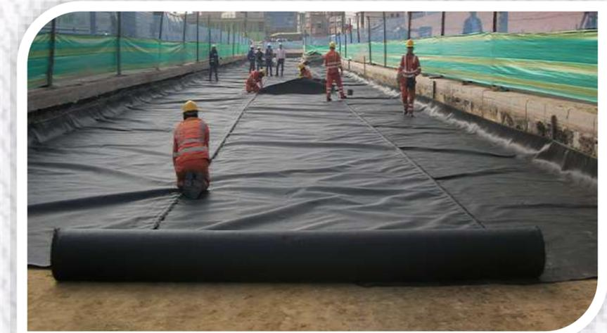
**GeoTEX SERIE H** Es un geotextil tejido con fibras de poliéster de alta tenacidad (PET), caracterizado por presentar alto desempeño mecánico e hidráulico, desde 30KN hasta 300KN.
