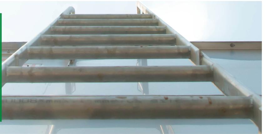
**Saviez-vous que les échelles fixes installées depuis le 3 janvier 2019 doivent être munies d'un dispositif d'arrêt de chute sur une corde d'assurance verticale tendue ou sur un rail vertical ?**
