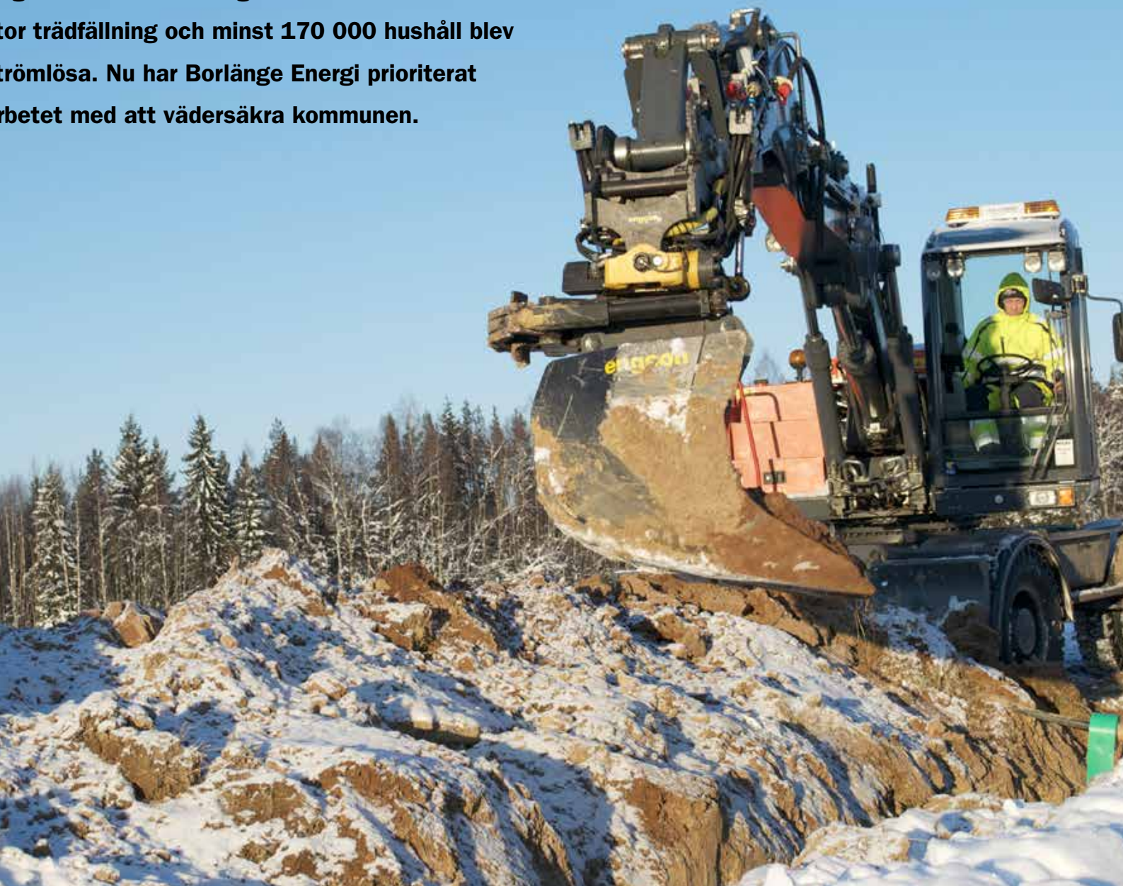
Nedgrävning av elledningar mellan Bomsarvet och Holländaren
