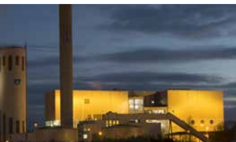
PLACERINGEN NÅGONSIN Borlänge Energis nya fjärrvärmevärmeverk är fjärde billigast i landet. SID 6
