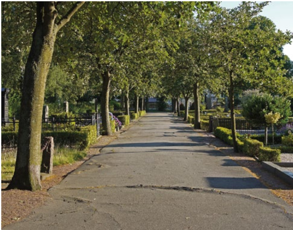
Rotuppträngning av oxlar på Sankt Pauli kyrkogård i Malmö. Trädens rötter skadar vägen och försämrar tillgängligheten, till exempel för personer som använder rullstol eller rullator. Rötterna ökar också risken för olyckor (risk för snubbling). Foto: Johan Östberg.
