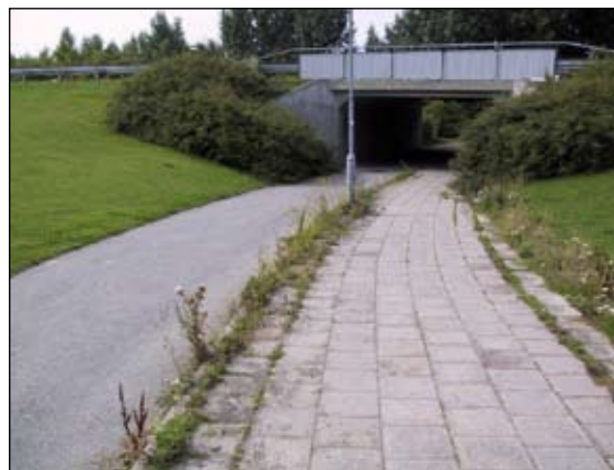
Före åtgärd: G/c-tunnel där buskage bidrog till en känsla av otrygghet.
