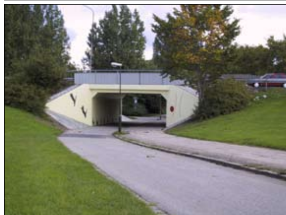
Efter åtgärd: Samma tunnel där buskarna tagits bort för att öka tryggheten.
