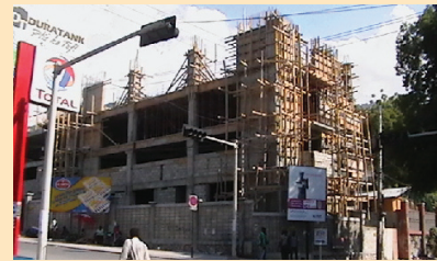
Le nouveau Collège en construction
