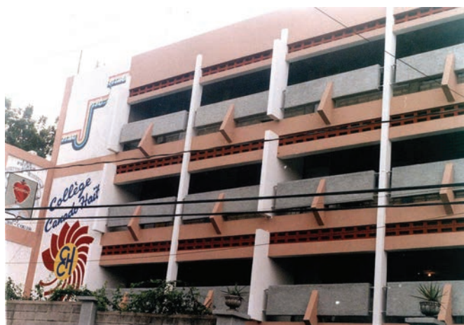
Le bâtiment du Collège Canado-Haïtien avant le séisme du 12 Janvier 2010
