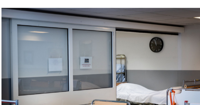
Når prosessen er ferdig etter en time og forti minutter, åpnes dørene automatisk gå opp: – Vi trenger aldri å bekymre oss for om det er noe farlig gass som sitter igjen i rommet, forteller avdelingsleder Kristin Stræte. Dørene og kanaler som fører ut av rommet er isolerte, slik at det ikke er helseskadelig. Foto: Werner Juvik
