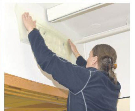
TETTING: For maskinen kan startes må luftkanaler testes. Her setter Elisabeth Håkellen på tape over ei luftluke.
