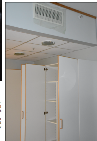
RENSER ALLE KRIKER OG KROKER: Tåka kommer til overalt. Skap og skuffer åpnes og ventilator dekkes med plastfilm før maskinene setter i gang.
