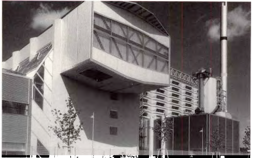
Die Thermische Abfallverwertung Donautal ist einer der ersten Müllöfen, der im Rahmen eines US-Lease vermietet wurde. Bis 2016 fließen jährlich rund eine Mio. DM in die Kassen des Verbands.
