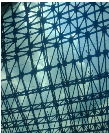
TRIDILOSA CON ESPESOR DE 10 MILIMETROS SOBRE ESTRUCTURA DE ACERO
