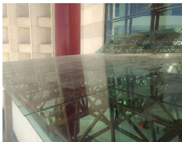
TRIDILOSA CON ESPESOR DE 10 MILIMETROS SOBRE ESTRUCTURA DE ACERO
