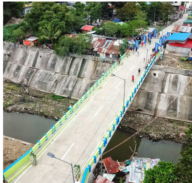
Binuksan na rugtong sa Barangay ang Tulay na nag du-Buhay na tubig at At
