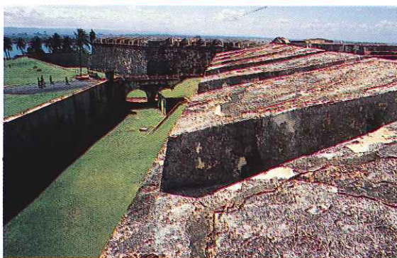
Reparaciones hechas por los españoles para corregir una de las roturas que produjo el terremoto de 1787 en las murallas del Castillo del Morro.
