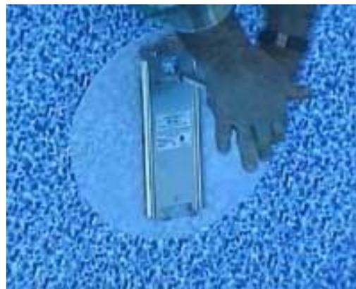
Enroulez un maximum de 2 3/4 enveloppements de cordon de sorte que la dernière enveloppe s'arrête au sommet de la lumière. Ce cordon supplémentaire vous permet d'apporter la lumière hors de la piscine installer une nouvelle lampe et pour l'entretien sur le pont.
