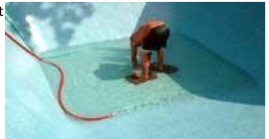
1. Piquer très soigneusement avec un couteau utilitaire le revêtement (environ 1/8 " fente) au centre des têtes des vis précédemment installés et en utilisant vos pouces pousser vers le bas et étirer le revêtement sur la tête de toutes les vis. Vis arrière à travers le revêtement en vinyle et rapidement positionner joint et
