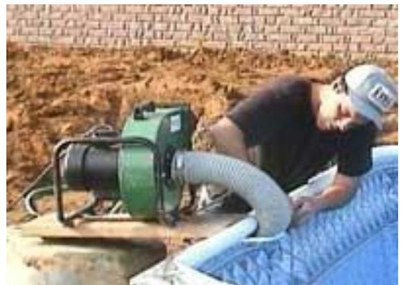
qui a les bords conduit scotché ou arrondi avec une râpe de bois et la position sur le sol serré contre l'étape et placez 2 sacs de sable sur la planche. Le défaut de prendre cette précaution peut entraîner un étirement excessif de la doublure lorsque la piscine est remplie et la force tirera le revêtement de sous la place du visage inférieur et une fuite se traduira.
