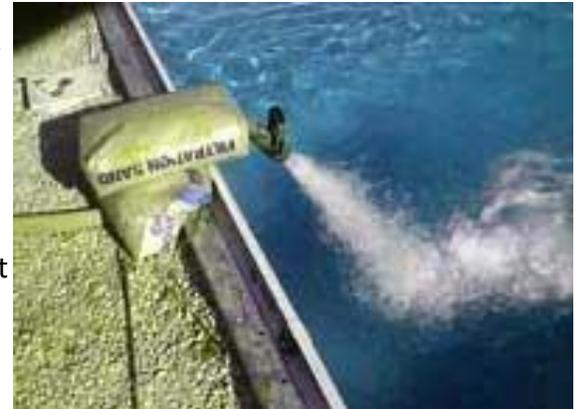
**Note: Lorsque vous commencez à déposer avec seulement 2' d'eau dans la trémie de la piscine, utilisez une plante 2x10 avec le tuyau fixé à la planche en mettant un clou de 20 penny sur les deux côtés du tuyau et du ruban adhésif ou sangle autour de la planche et le tuyau en toute sécurité.**
