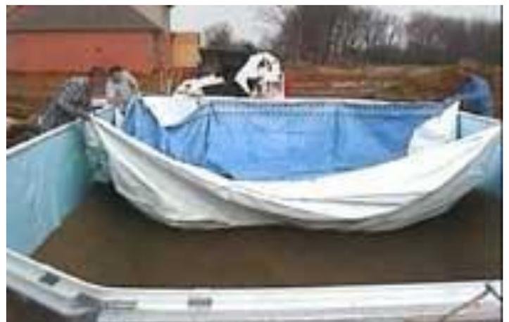
Placez le revêtement au mur d'extrémité peu profond et déroulez vers le bas le centre de la piscine dans l'extrémité profonde. Commencer l'installation de l'extrémité peu profonde de l'alignement de la piscine comme c'est le #1 de la méthode.
