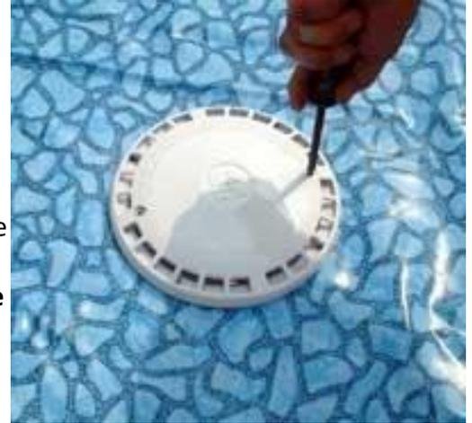
Continuer à remplir la piscine d'eau. Il peut être nécessaire d'enlever certaines rides pendant l'opération de remplissage. Les rides doivent être enlevées avant d'être recouvertes de plus de deux pouces d'eau. Si des rides subsistent, pompez l'eau. Enlever les rides et remplir la piscine. Évitez cette erreur coûteuse et chronophage en éliminant les rides avant qu'elles ne soient recouvertes d'eau ou utilisez un piston de placard à eau. (voir les indications ci-dessous)
