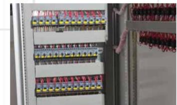
Suministro e instalación de CCM para 34 motores con arranque directo.
