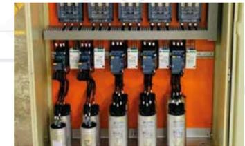
Suministro e instalación de bancos de capacitores de 100 kVAR de 5 etapas automático.
