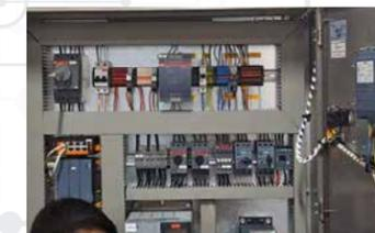
Mantenimiento de panel de control, levantamiento de diagrama eléctrico, etiquetado de dispositivos y cableados.
