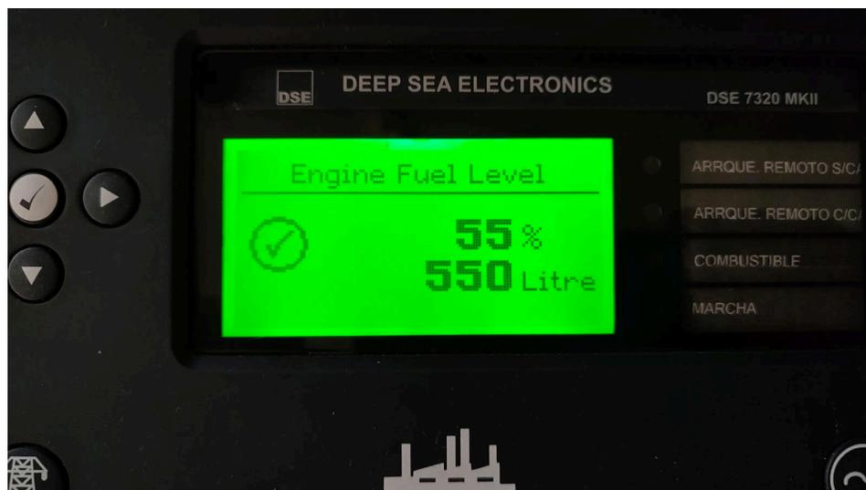
Fig 15 Vista de la lectura de nivel de combustible en la pantalla de Cristal líquido del módulo.
