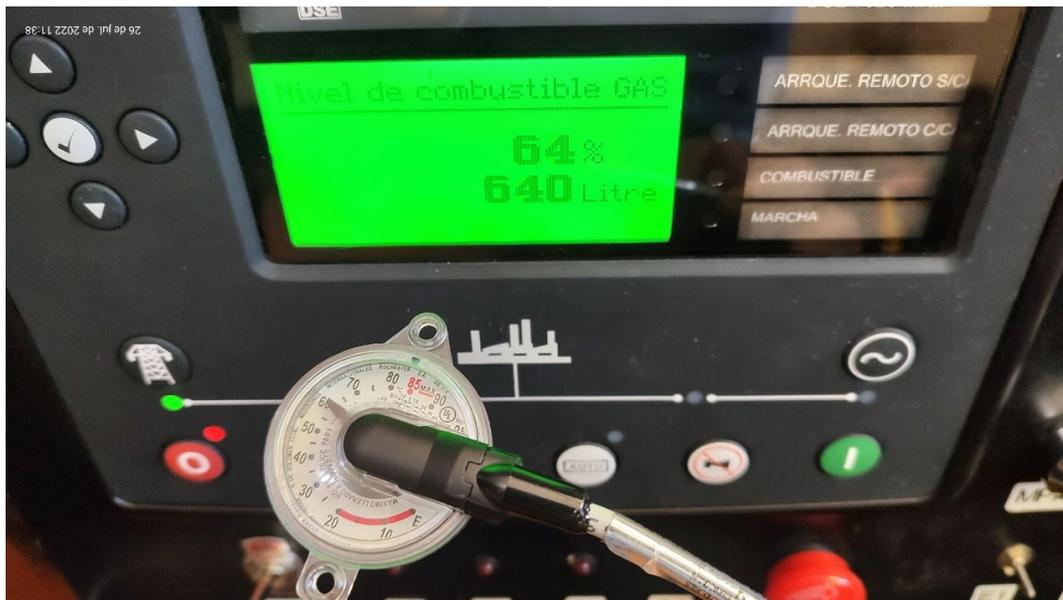
Fig 13 Lectura de nivel de gas LP mostrada en la pantalla de Cristal líquido del módulo.
