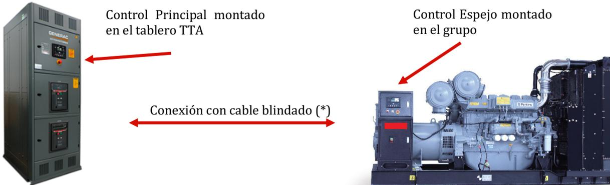
**Fig. 2 Grupo generador y tablero con pantalla remota "Espejo"**
