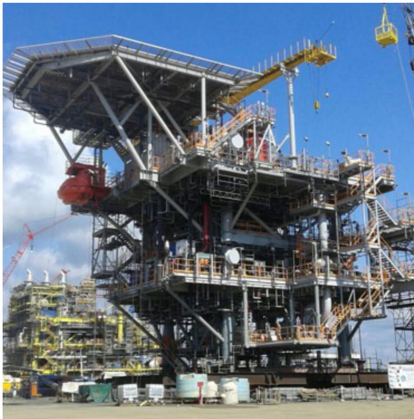
Ensamble de plataforma de aluminio Helidex para montaje en plataforma petrolera. Instalación del sistema de iluminación del helipuerto.
