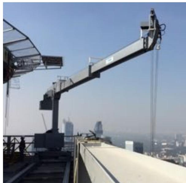
Fabricación, suministro, elevación, instalación y puesta en marcha de equipo para mantenimiento de fachadas tipo MUSTANG de TRACTEL-SECALT, con brazo fijo de 14 metros de longitud y mástil fijo de 4 metros con una plataforma de 2 metros con sistema de acercamiento. La máquina se traslada por medio de un recorrido de rieles en la azotea del edificio.
