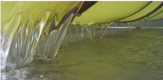
A filtração ocorre por gravidade e é contínua, com perda de carga insignificante. A lavagem é feita continuamente, sem necessidade de água externa. A unidade tem sistema de transbordamento integral para quando a taxa máxima de vazão ou concentração de sólidos for ultrapassada. O sistema desvia a água de transbordamento não filtrada para a descarga dos sólidos. Dessa forma, a qualidade da água filtrada é mantida.
