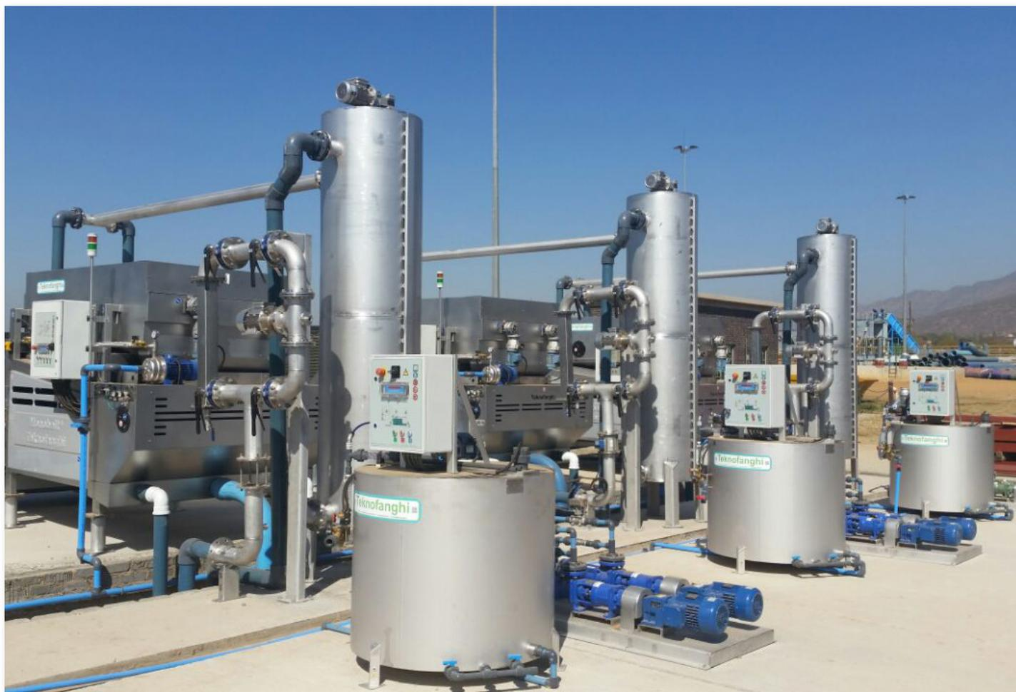
O equipamento é fabricado conforme os altos padrões costumeiros da TEKNOFANGHI, usando materiais não corrosivos da melhor qualidade, com todas as peças metálicas fabricadas com aço inoxidável 304L. Mediante solicitação, temos disponível execução em AISI 316L ou polipropileno.
