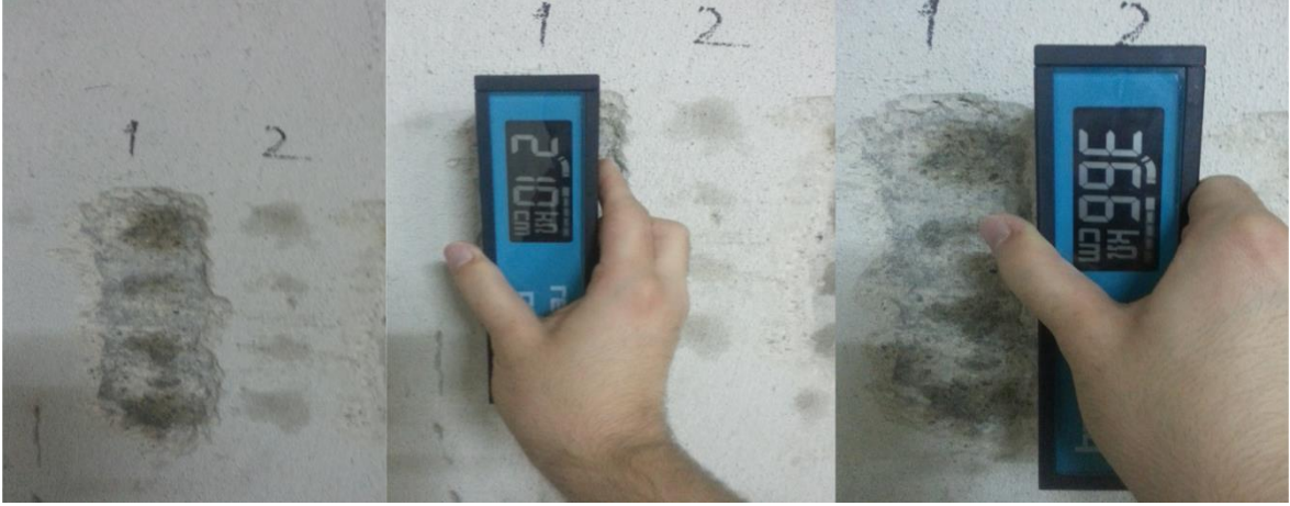
Şekil 73. Sıvalı ve sıvasız yerde ölçüm
