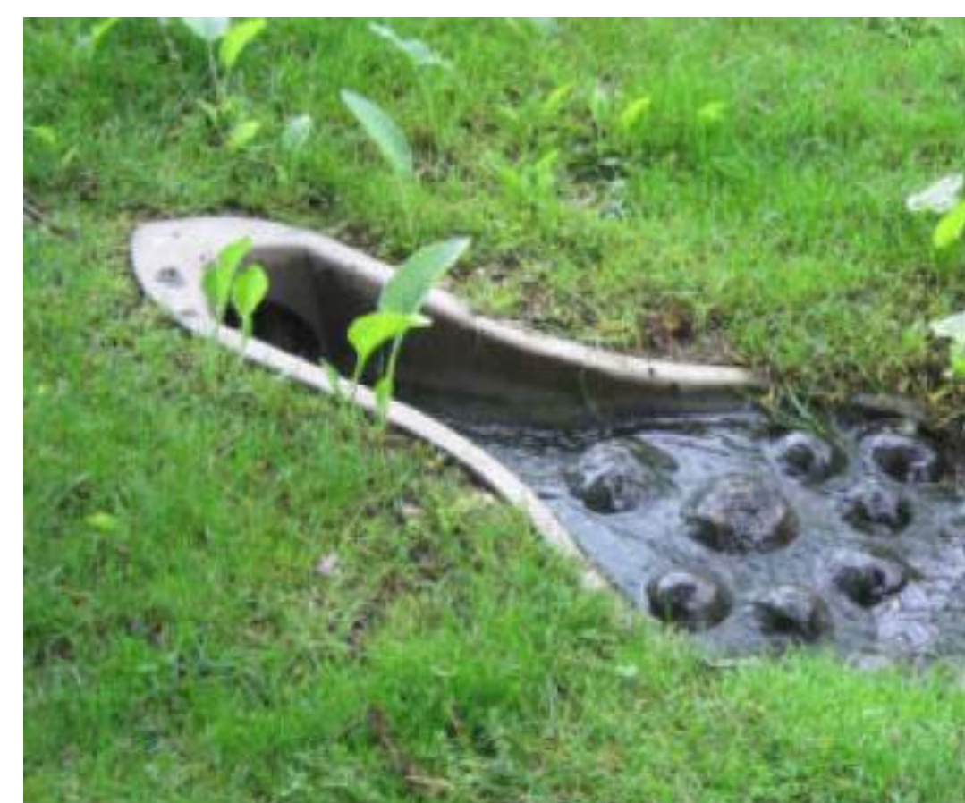
Section Prestige 225 Litre Attenuation SuDS Planter
