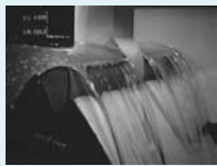
V10.15 Spillway gate
