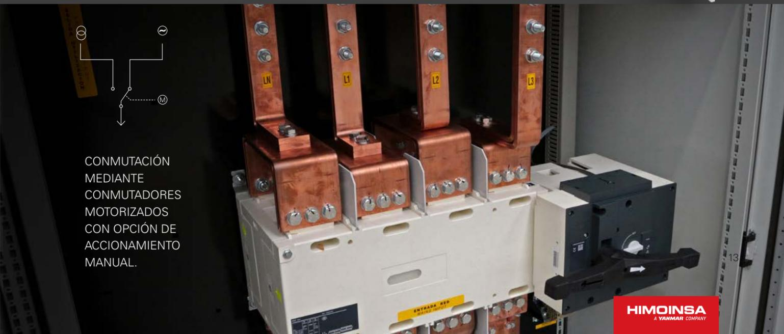
CONMUTACIÓN MEDIANTE CONMUTADORES MOTORIZADOS CON OPCIÓN DE ACCIONAMIENTO MANUAL.
