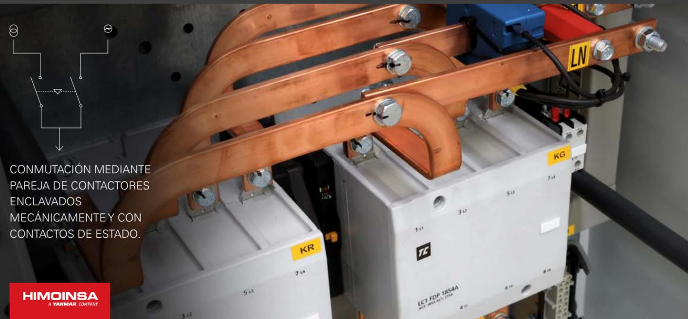
CONMUTACIÓN MEDIANTE PAREJA DE CONTACTORES ENCLAVADOS MECÁNICAMENTE Y CON CONTACTOS DE ESTADO.
