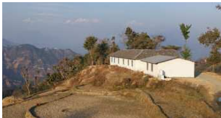
Die von HTC 1999 erbaute Sangibani Primary School in Haleda/Naldum
