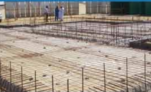
STEP 1 | Pour base slab
