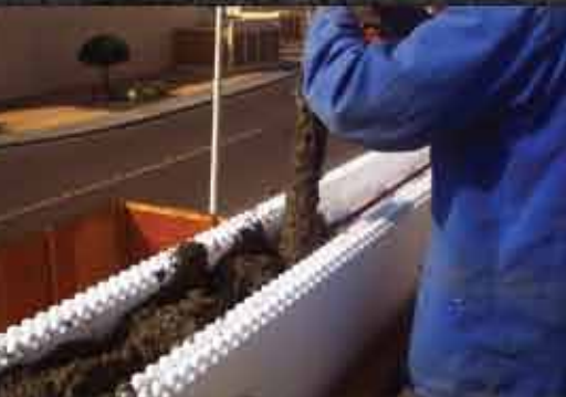
STEP 4 | Pour the concrete
