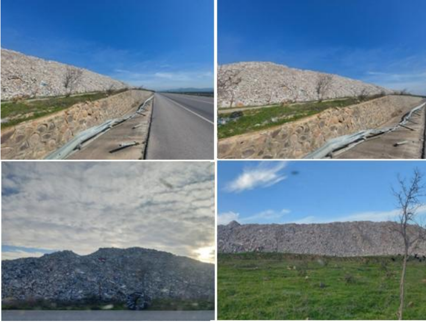
Şekil 3. Depremde yıkılan binaların yıkıntılarından oluşan hafriyat atıklarının toplanma alanı (Baykanoğlu, 2023)
